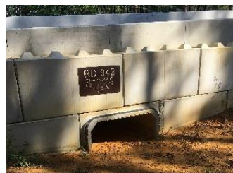
Coupe de principe et photo du batrachoduc ©Département de Vaucluse
