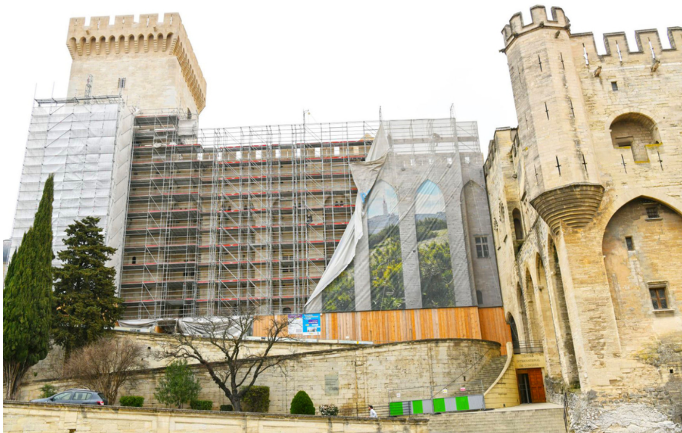
L'immense bâche en trompe-l'œil a été enlevée, révélant partiellement la blancheur éclatante retrouvée de la façade.
