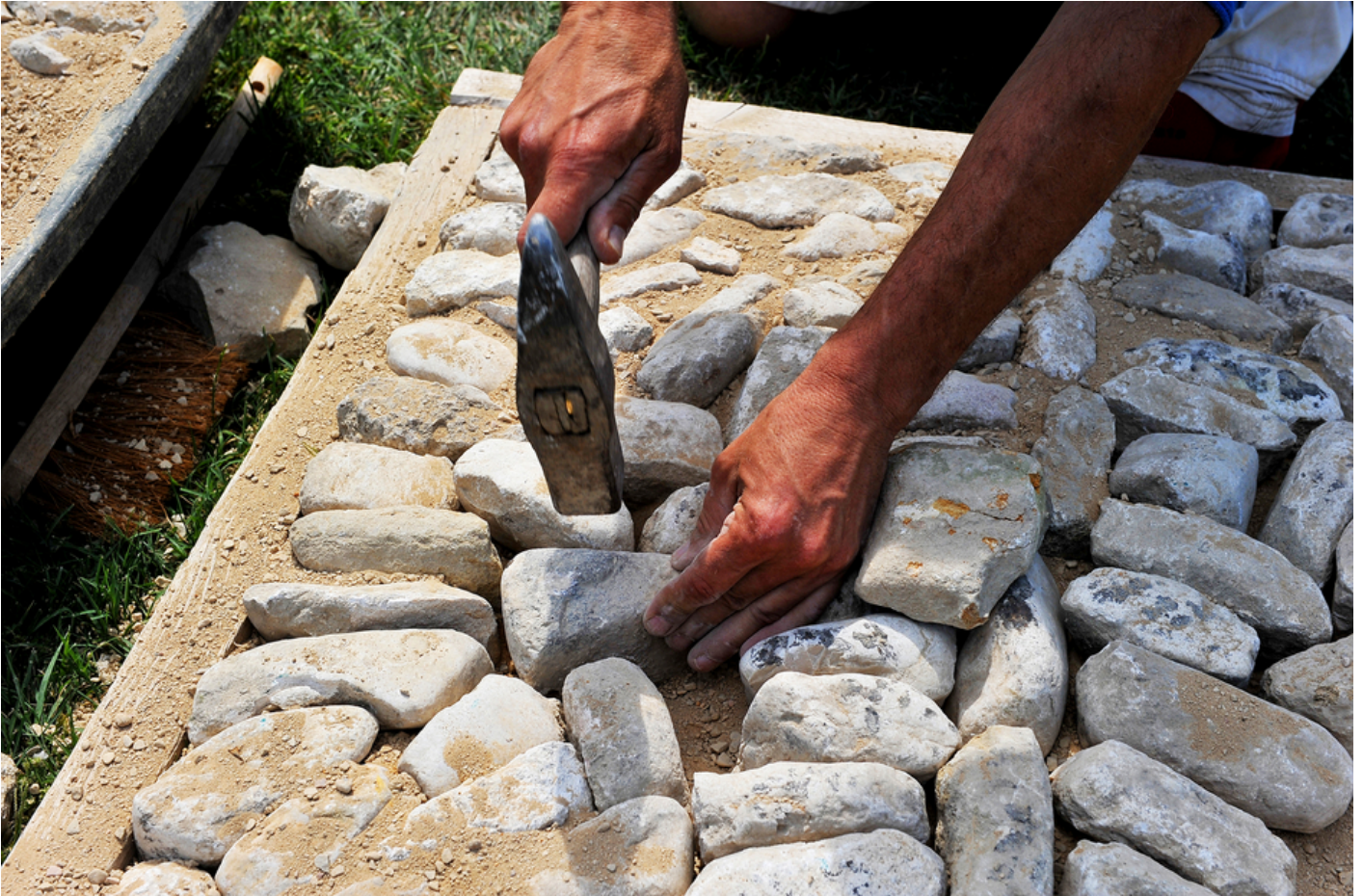
Les ouvrages traditionnels en pierre sèche constituent l'un des traits identitaires du Vaucluse.
