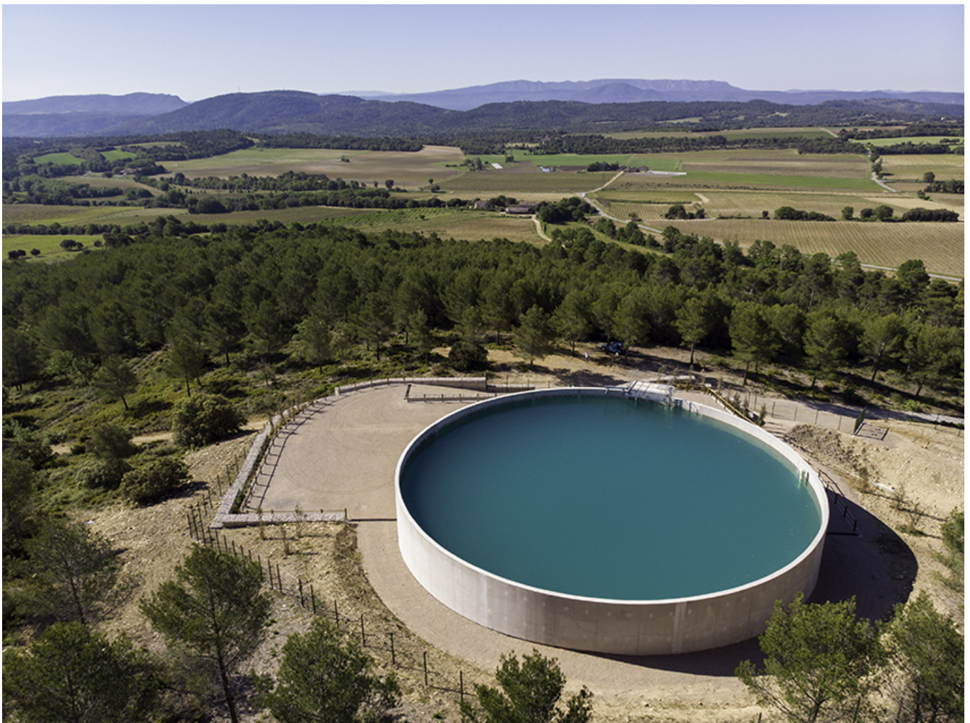
D'une capacité de 4 000 m 3 , le réservoir de Mirabeau est en service depuis l'an dernier. (Photo SCP)
