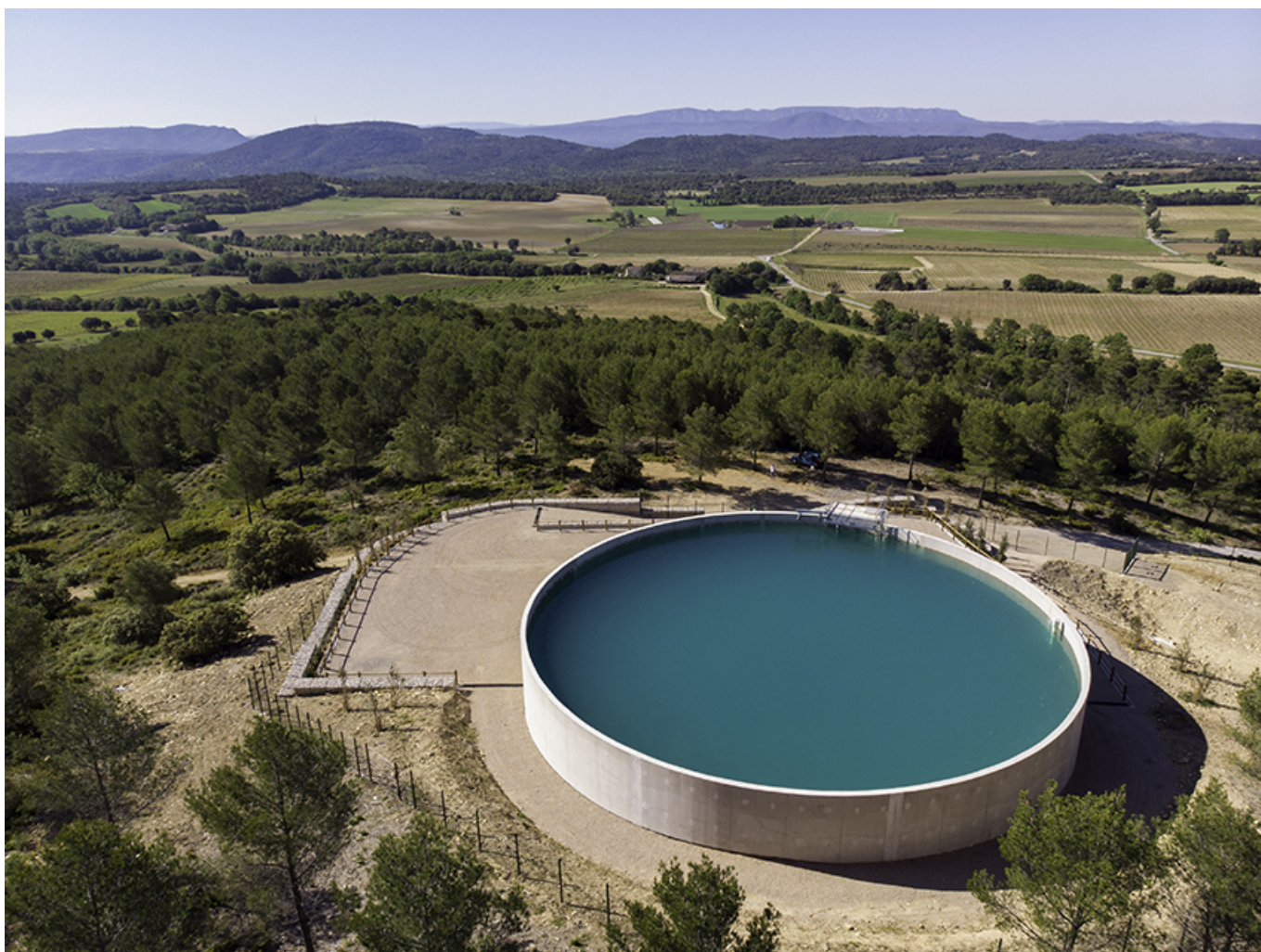
D'une capacité de 4 000 m 3 , le réservoir de Mirabeau est en service depuis l'an dernier. (Photo SCP)
