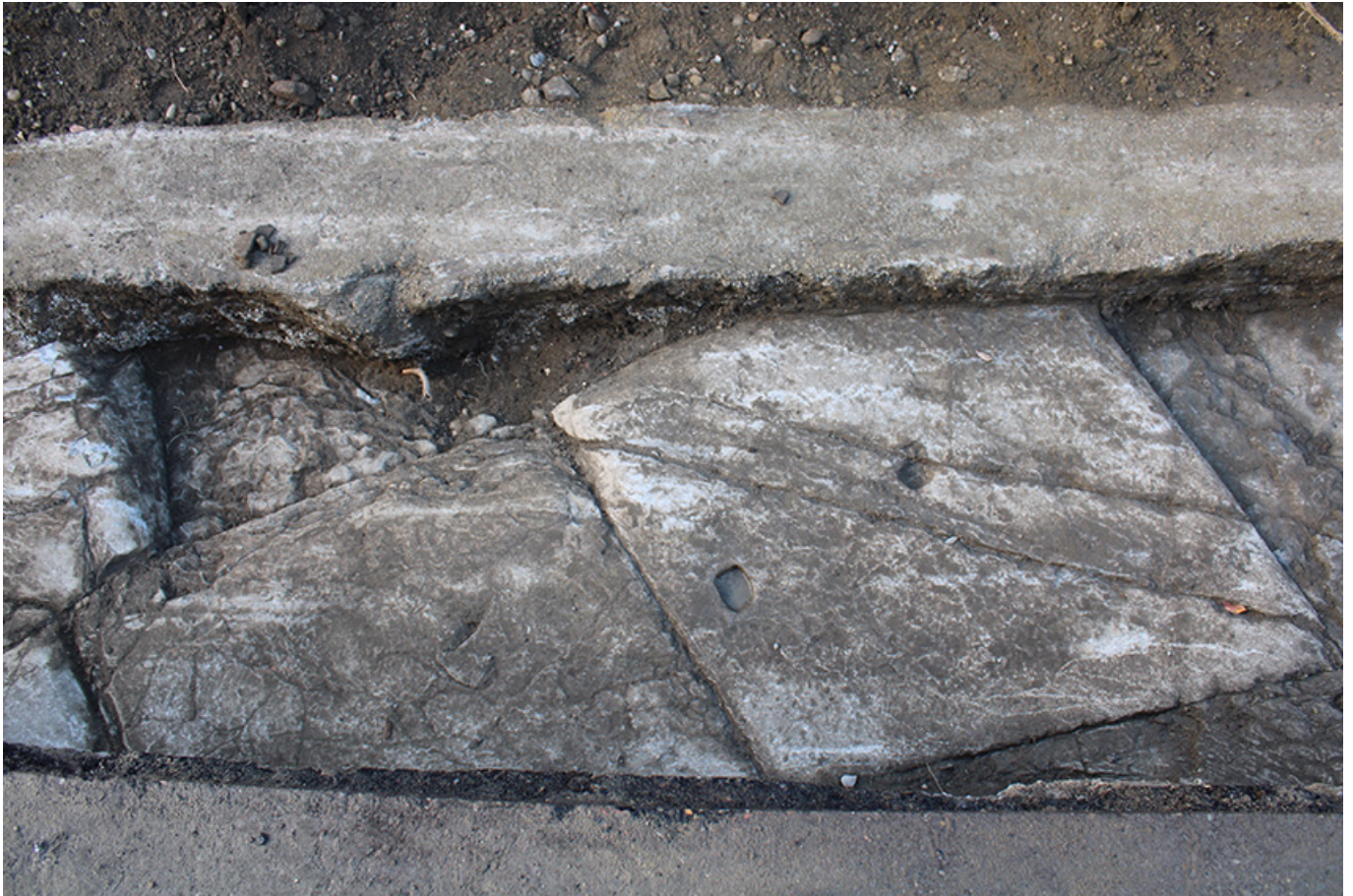
On aperçoit bien au centre des pierres les trous caractéristiques de l'utilisation d'un outil qui s'appelle la louve, qui permettait de lever les pierres.
