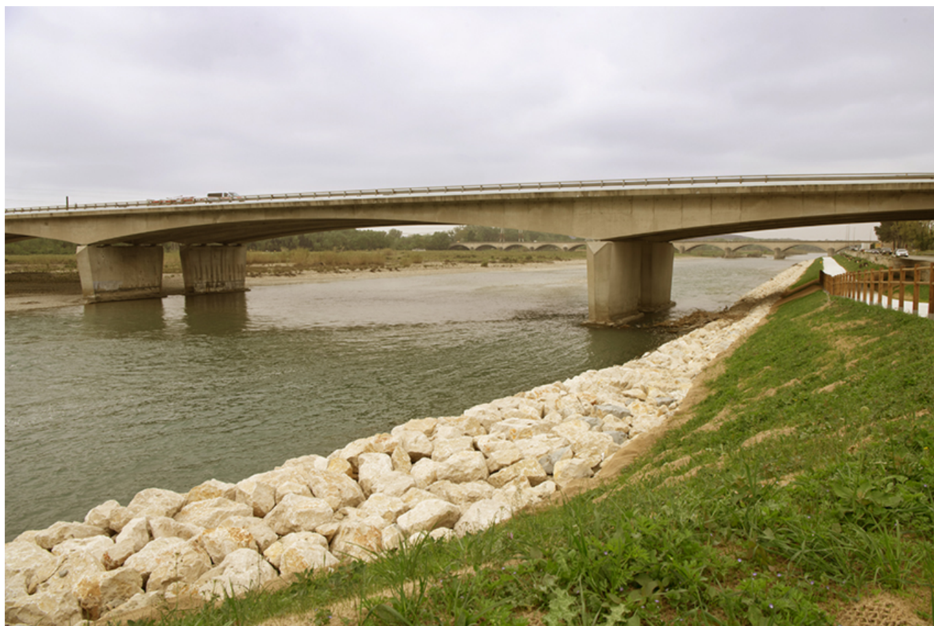
A Bonpas, 40 000 m 3 de déblais et de remblais et 34 000 tonnes d'enrochement ont été posés.
