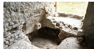
Négatif d'une cuve destinée à recueillir le jus de raisin aménagée dans le sol du cellier situé en rez-de-chaussée du château comtal de Vaison-la-Romaine.
