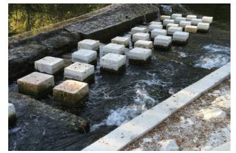
Passé à poissons réalisée sur la Sorgue par le Syndicat Mixte des Sorgues
