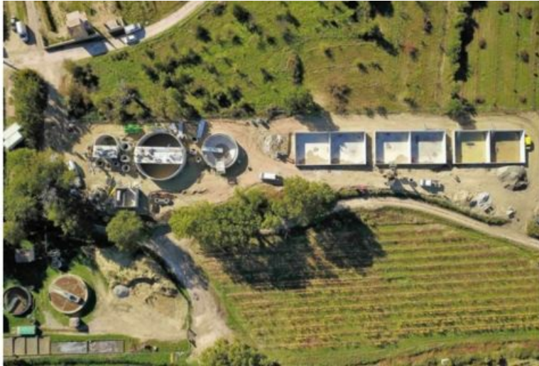
STEP * en construction de Malemort-du-Comtat
